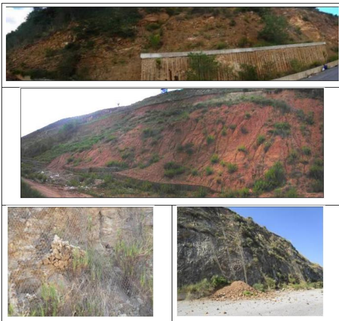
Fig. 4.2: interventi di messa in sicurezza
