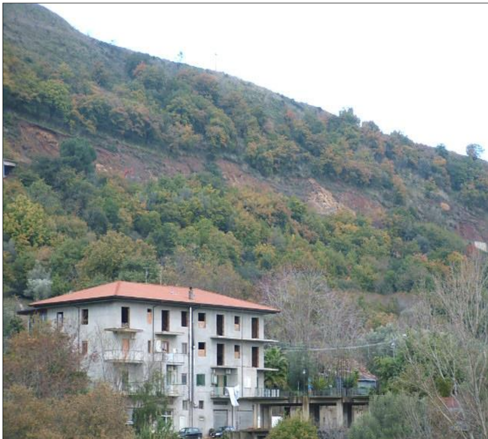
Fig. 2.4: Scorcio della faglia normale NE-SW a monte dell'abitato di Stefanaceni
